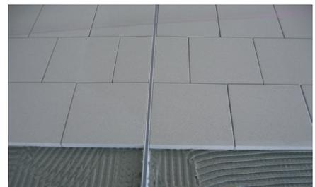
9. Las juntas de expansión y movimiento deben instalarse donde se especifique. Sugerimos usar las juntas de expansión Blanke para este propósito: BLANKE FLOOREX, BLANKE Surface Expansion Joint, or BLANKE HD Expansion Joint.
