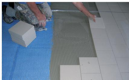
8. Frühestens nach 24 Std. können die verlegten Fliesen mit Flexfuge nach EN 13888 CG2 verfugt werden.
