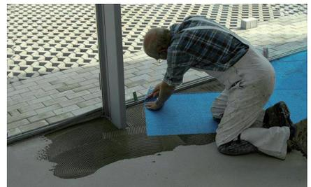
6. Corte BLANK PERMAT al tamaño correcto con tijeras o cuchilla según sea necesario para ajustar la superficie del piso.
