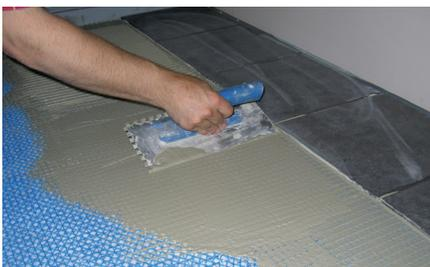
7. Die Vertiefungen der Gitterstruktur werden mit Fliesenkleber gleichmäßig abgepachtelt. Mit der auf die Fliese abgestimmten Zahntraufel wird dann der Fliesenkleber frisch in frisch aufgekämmt und die Fliesen eingelegt.
