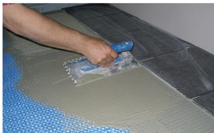
7. Rellene las cavidades de la estructura de fibra de vidrio de manera uniforme con mortero delgado. Luego aplique suficiente mortero en el área, humedezca sobre mojado, luego peine usando una llana dentada apropiada para la instalación de losetas o piedras. Incrustar las fichas en thinset.
