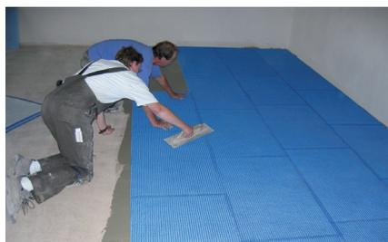
5. Incruste la parte inferior del forro polar (lado blanco hacia abajo) en el nuevo mortero de capa fina para que toda su superficie esté unida. Presione la estera en el mortero usando un flotador o un rodillo. Debe compensar las juntas de BLANK PERMAT por al menos 10 cm (4 ").
