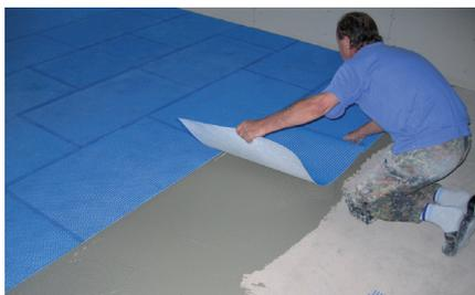
4. Die Matten sind auf einer Kopf- bzw. auf einer Längsseite mit einem überstehenden Glasgittergewebe ausgestattet (3,0 cm). Dieses ist zum Verbinden der Stoßbereiche vorgesehen. Eine weitere Armierung der Stöße ist nicht erforderlich. Die einzelnen Matten werden dicht gestoßen.
