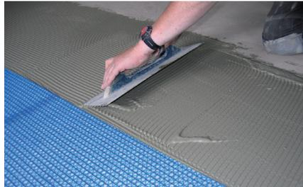
2. El tipo de mortero utilizado para aplicar BLANK PERMAT debe ser adecuado para el sustrato de acuerdo con las recomendaciones del fabricante. Aplique un mortero de espesor reducido mezclado al sustrato utilizando una llana dentada de 1/4 "x 1/4". La consistencia debe ser ligeramente más líquida de lo normal para permitir la absorción en la parte inferior del forro polar de la estera.
