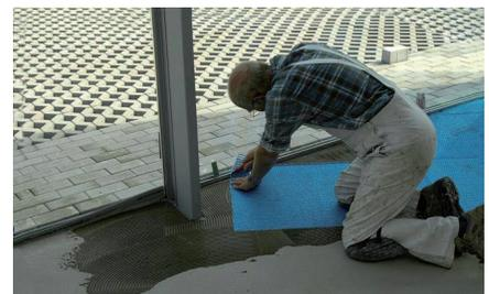
6. Der Zuschnitt der Entkopplungsmatten auf das erforderliche Maß erfolgt mit einem Messer oder Schere. Nach dem Einlegen der BLANKE PERMAT in das frische Fliesenkleberbett ist die jeweilige Abbindezeit des verwendeten Dünnbettmörtels abzuwarten.
