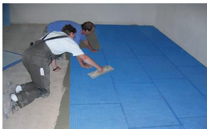
5. Die Entkopplungsmatte vollflächig in den klebefreien Verlegemörtel mit dem Spezialvlies nach unten (weiße Seite) einlegen und mit Hilfe eines Reibbretts bzw. einer Andruckwalze andrücken. Die Matten müssen mindestens 10 cm versetzt werden.
