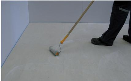
1. Untergründe müssen frei von haftungsfeindlichen Bestandteilen sein. Die Ebenheit muss der DIN 18202 entsprechen. Der Untergrund muss tragfähig und fest sein. Abgestimmt auf den Untergrund ist gegebenenfalls eine Grundierung aufzubringen.
