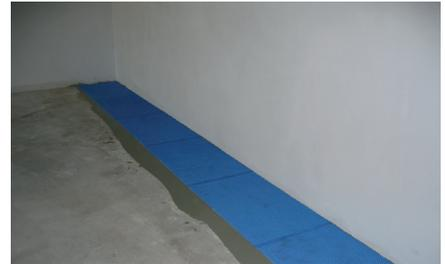
3. No instale BLANK PERMAT al ras contra una superficie vertical (es decir, pared o columna de soporte); en su lugar, deje un espacio de 1/4 "entre la alfombra y cualquier superficie de restricción; pared, punta del gabinete, escalera elevadora. Usa un cuchillo para cortar cualquier colchoneta sobrante. Coloque BLANK PERMAT comenzando en la esquina de izquierda a derecha.
