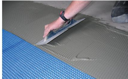
2. Fliesenkleber nach DIN 12004 C2 bzw. 12002 S1 mit einer Zahntraufel 4er oder 6er auf den Untergrund auftragen. Zu aufsteigenden Bauteilen sind Einspannungen zu verhindern.
